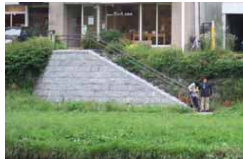
石積階段設置後
