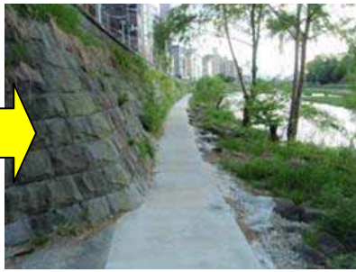
散策路設置後
