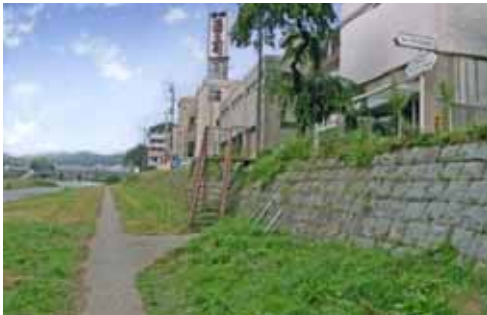
石積階段設置前
